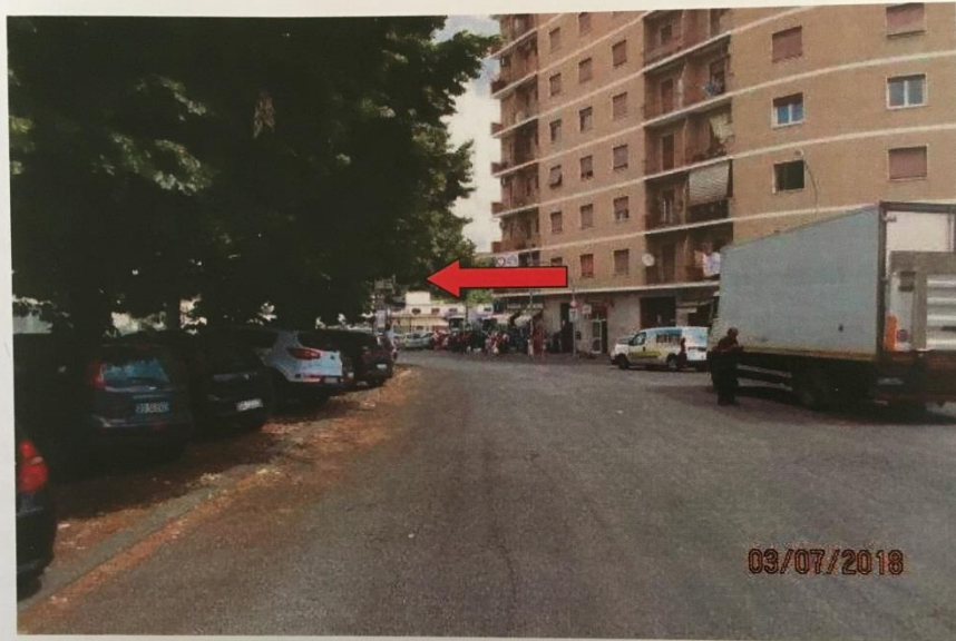
5) Fotocolor di inizio delle operazioni peritali: la freccia rossa evidenzia la presenza di fronde di rami che oscurano la segnaletica verticale indicante divieto di transito eccetto bus di linea e taxi (Via di Portonaccio f.c. 33 - distanza inferiore a 50 Metri).
